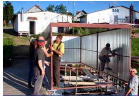
2010 r Stawianie hangaru na motorówkę.
