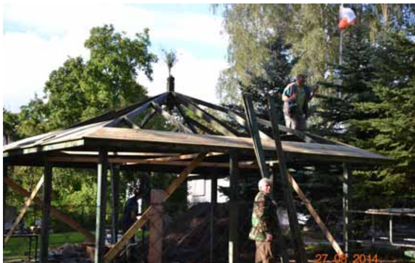
Montaż nowej wiaty na terenie stacji.
