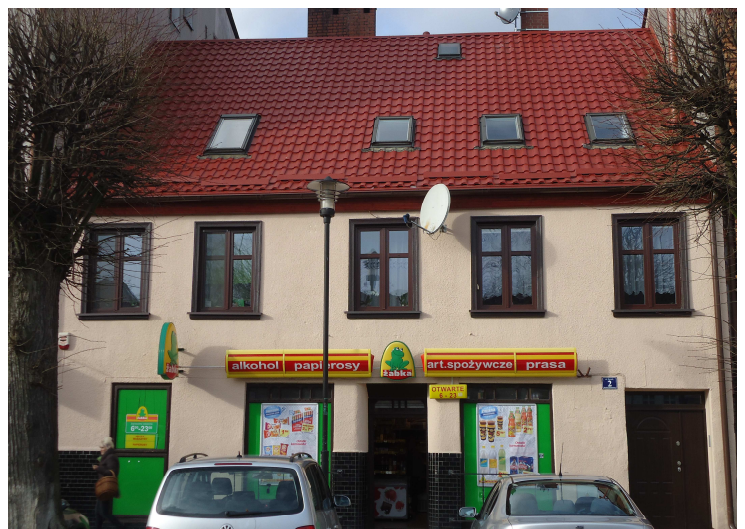
ul. Rynek 2 elewacja i nowe pokrycie dachu
