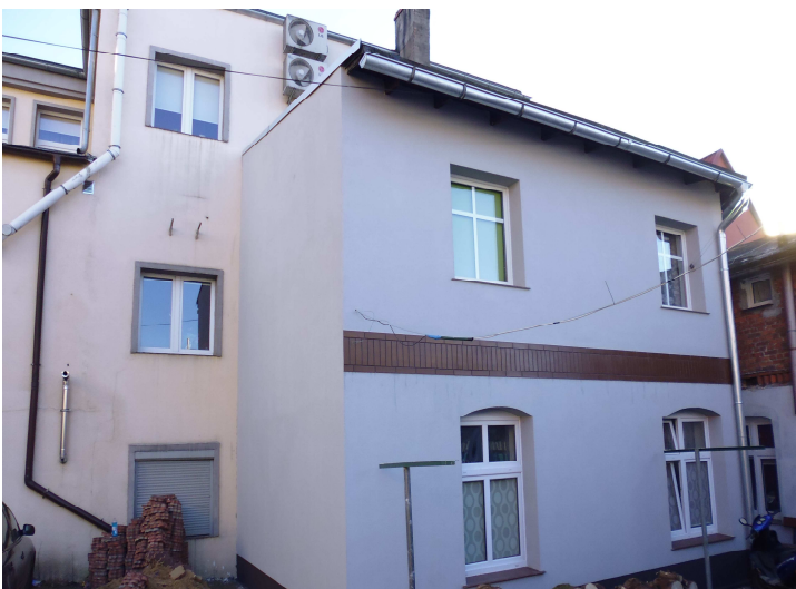
ul. Długa 6 przybudówka z dociepleniem ścian i fundamentu
