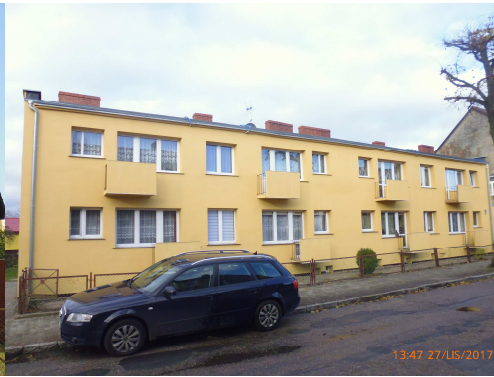
ul. Czarnkowskiego 6 elewacja z dociepleniem, remont klatek schodowych, system zbiorczej TV
