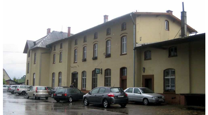
6. 2015 r. Prywatne samochody czekające przed dworcem na przyjazd pociągu. (fot. Zb. Januszaniec)
