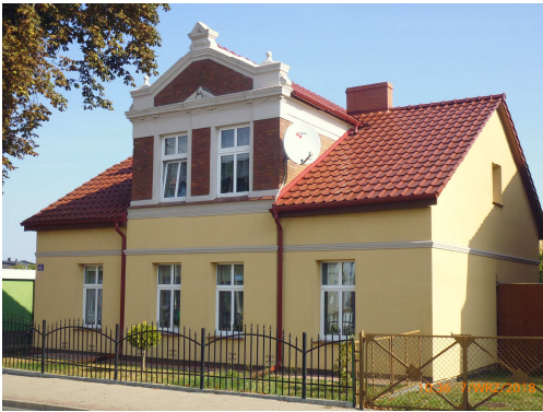
ul. Wałęcka 55 elewacja z dociepleniem, brama wjazdowa na posesję, wcześniej pokrycie dachu i remont kominów
