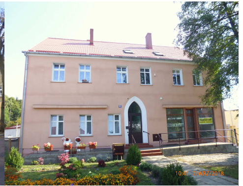
ul. Wałęcka 41 elewacja z dociepleniem, pokrycie dachu, remont klatki schodowej, ogrodzenie i trawniki
