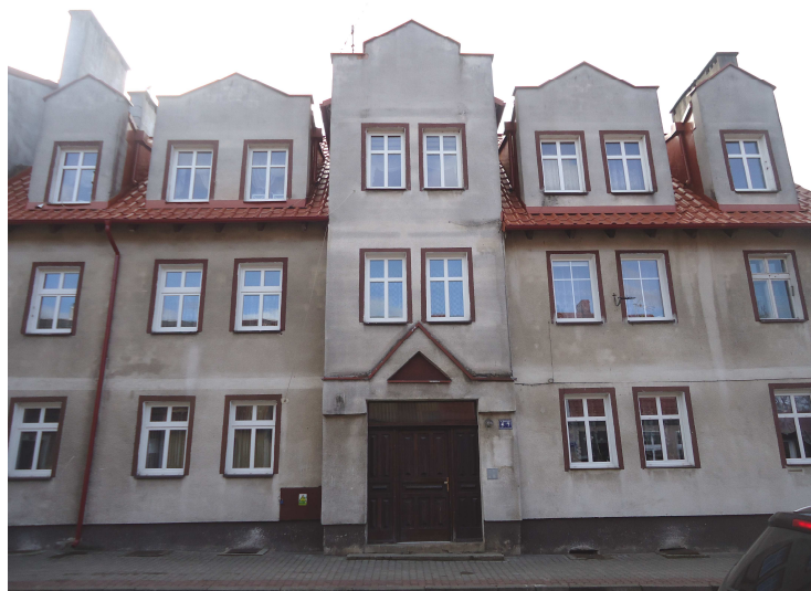
Moniuszki 5-7 remont dachu
