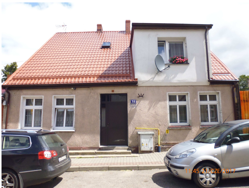
Moniuszki 34 remont dachu i kominów
