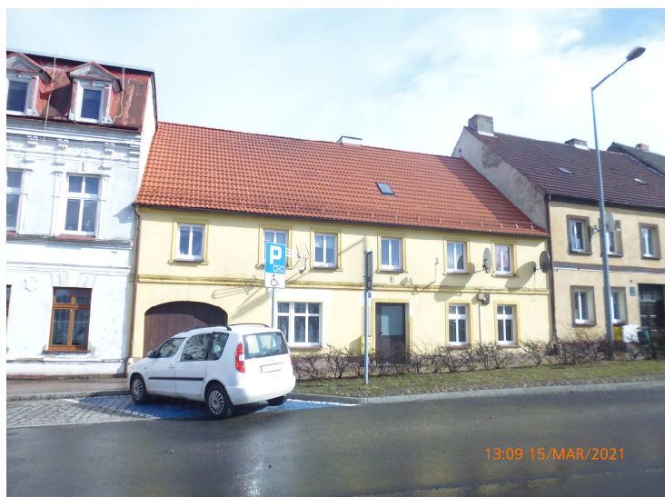
Wałęcka 11 remont dachu i kominów
