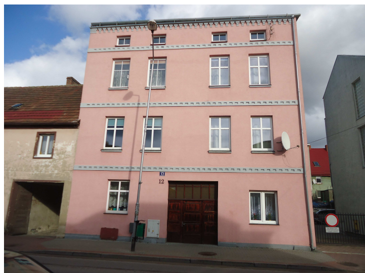
Długa 12 remont dachu i elewacji
