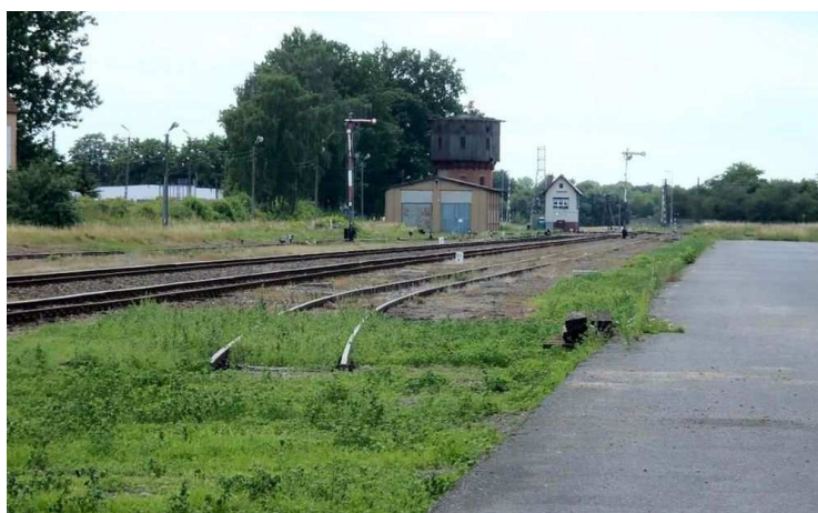
8. Widok z poziomu nawierzchni placu przeładunkowego. Pozostałości po zlikwidowanym torze, służącym niegdyś do podstawiania klientom kolei wagonów do rozładunku i załadunku (źródło: www.bazakolejowa.pl , fot. „octanq”, 2015 r.)
