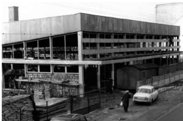
Pawilon AGD przy ul. Długiej w budowie. 1976 r.
