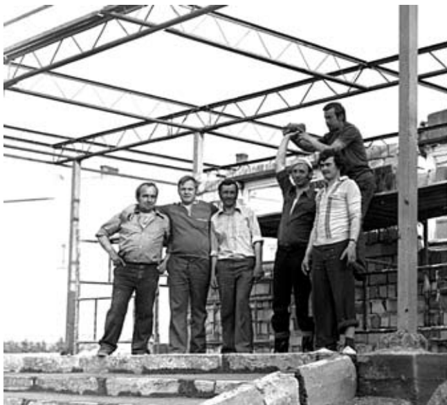
1976 r. Pracownicy zakładu pracują w czynie społecznym przy budowie przystanku autobusowego
