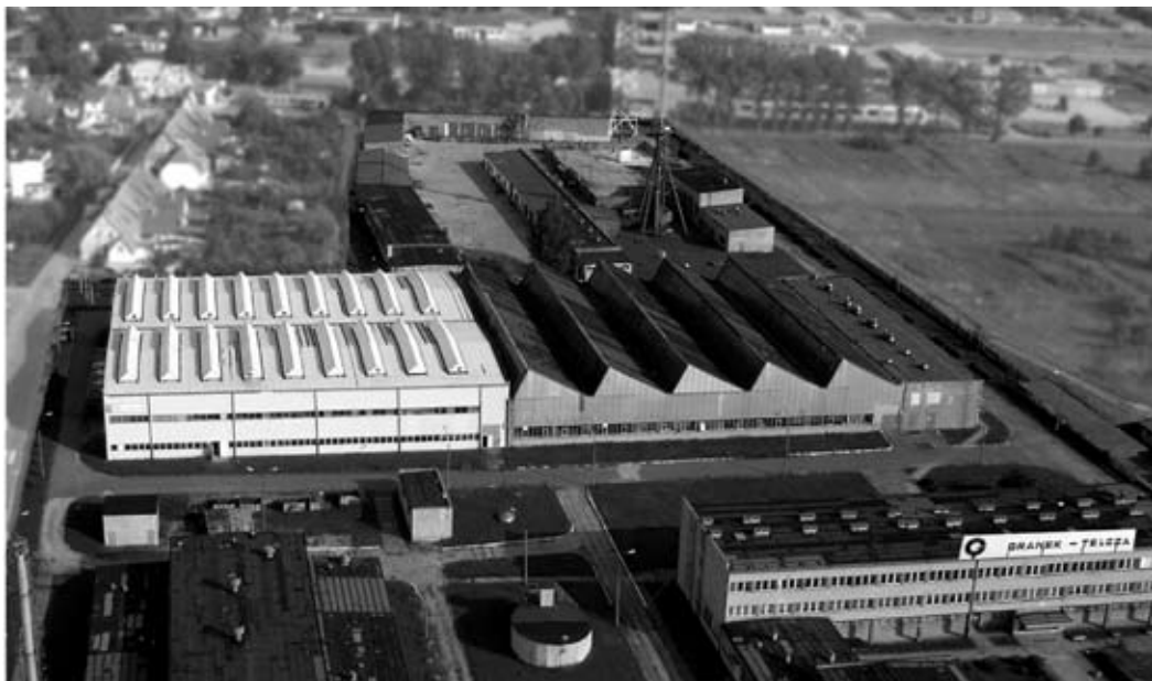
Zakłady TELCZA zbudowane trudem załogi. 1967-2007 r.
