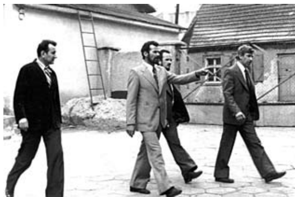
1975 r. Wizytacja budowy. Od lewej: A. Hrynkiewicz, R. Żukowski, M. Kaczmarek i S. Szczepański
