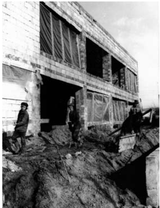
Zajazd „Czapla” przy ul. Drahimskiej w budowie. 1976 r.
