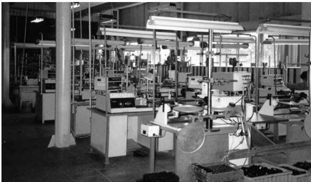
1980 r. Wydział Transformatorów - szwajcarskie nawijarki do cewek METEOR
