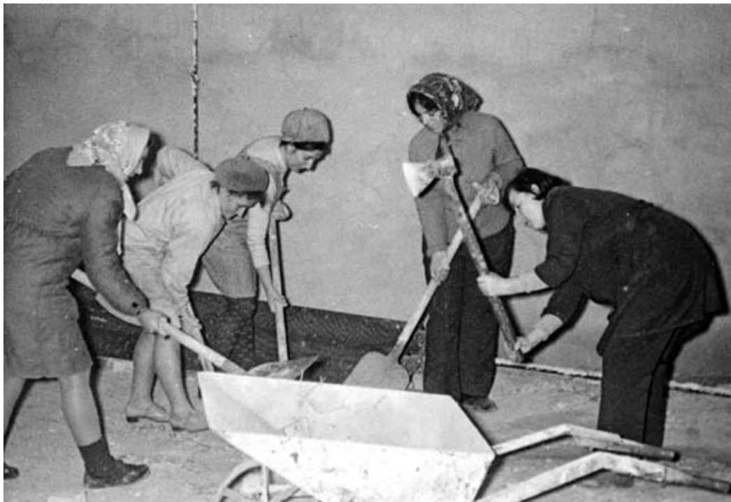
1971 r. Porządkowanie pomieszczeń w nowej hali
