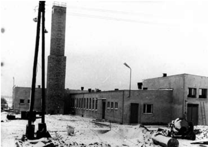
Masarnia i ubojnia przy ul. Dworcowej w budowie. 1976 r.
