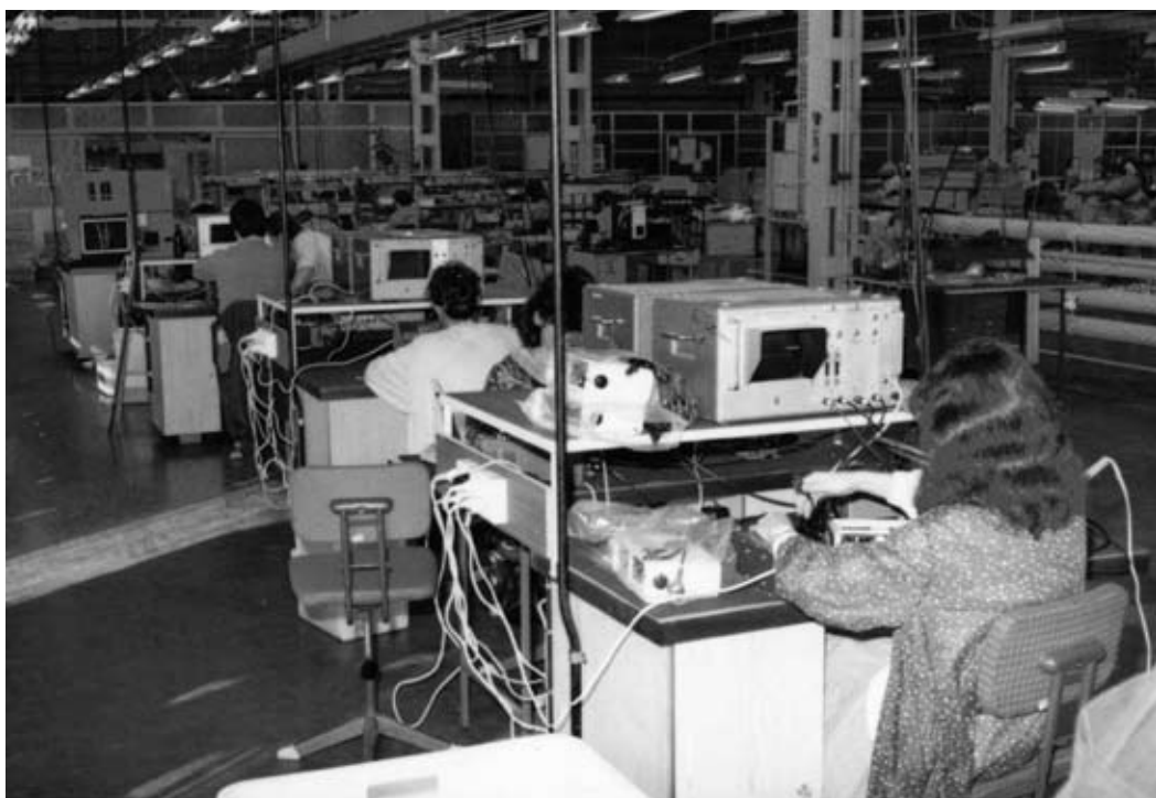
1988 r. Wydział Montażowy. Regulacja i strojenie odbiornika radiowego Czapla
