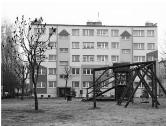
Nowo wykonana elewacja SM Czaplinek ul. Walecka 58
