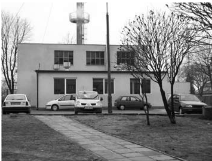
Kotłownia SM Czaplinek
