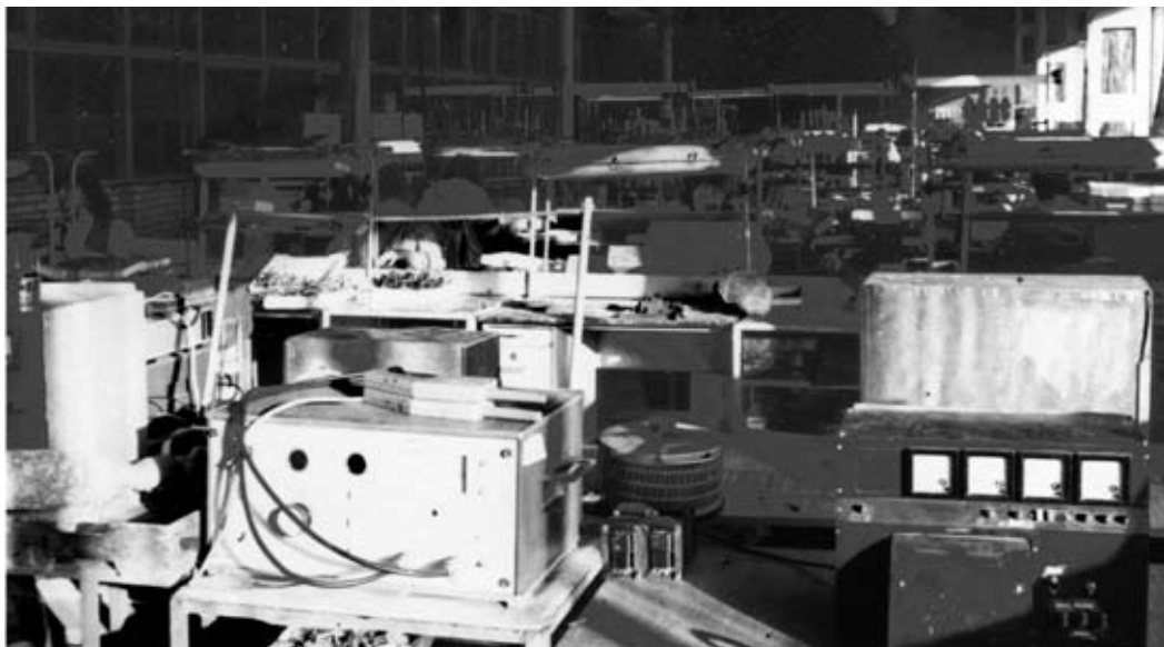
1994 r. „ TELIN ” oddział transformatorów
