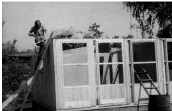
Maj 1981 r. – montaż Stacji Wędkarskiej
