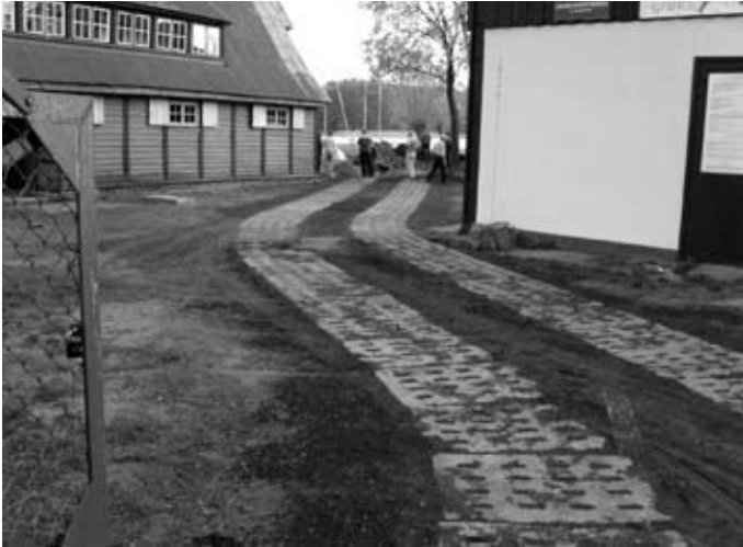
Budowa drogi do slipu
