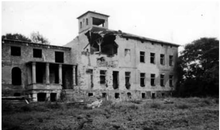
Pałac w Rzepczynie - początek odbudowy - 1995 r.
