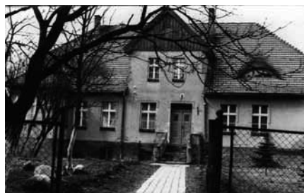
Budynek plebani zbudowanej w 1920 r.
