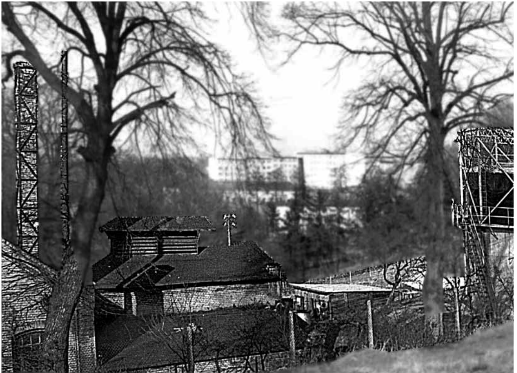
Widok gazowni od ul. Złocienieckiej.
