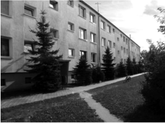
Ogólny widok bloku.
