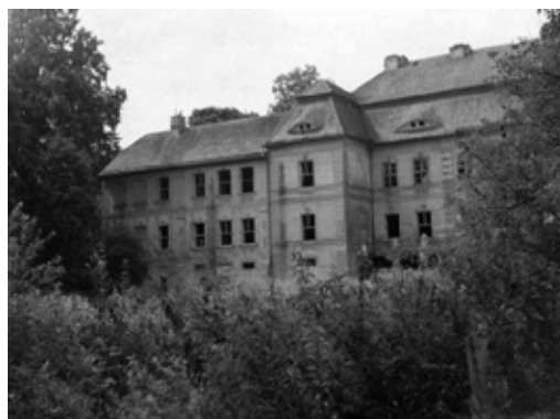
Zdjęcia z końca lat 40-tych, jeszcze przed rozpoczęciem remontu.
