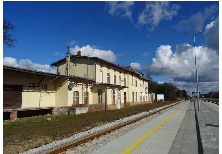
11. Stacja kolejowa po modernizacji, widok w kierunku wschodnim (fot. Zb. Januszaniec, marzec 2021 r.)
