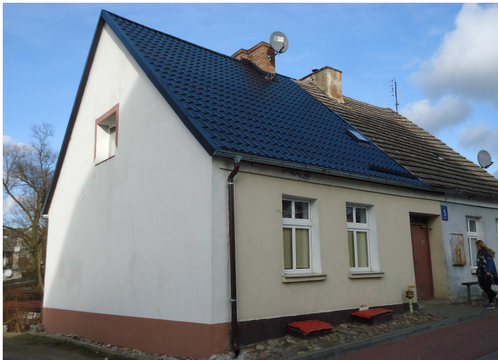
Rzeczna 9, remont dachu i elewacja
