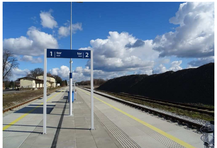
12. Czaplinska stacja jest już po modernizacji, ale obok torów leżą zwały kruszywa przeznaczone do trwających jeszcze prac modernizacyjnych na innych odcinkach linii 210, (fot. Zb. Januszaniec, marzec 2021 r.)
