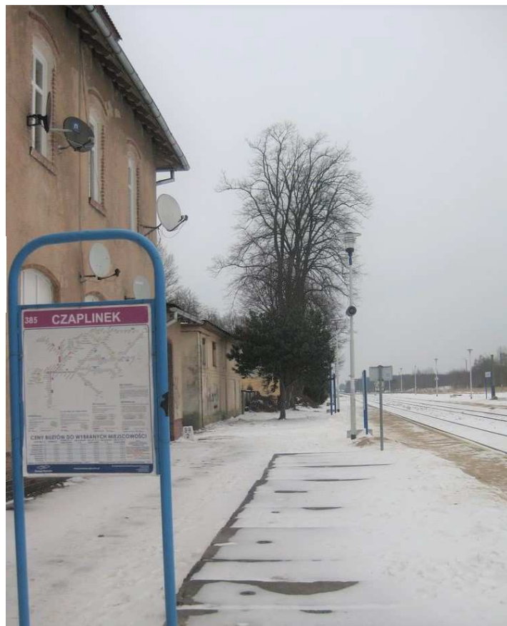
2. Zaśnieżone płyty na peronie 1 nad wejściem do nieczynnego tunelu (fot. Zb. Januszaniec, styczeń 2014 r.)
