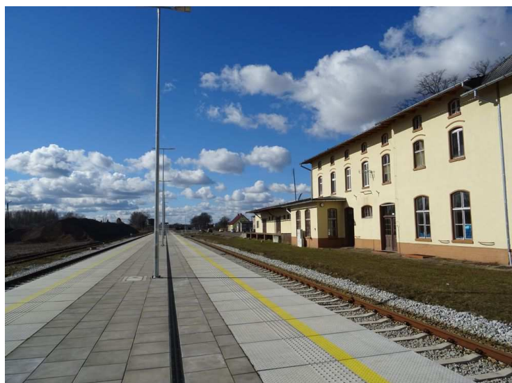
7. Prace modernizacyjne na stacji kolejowej, widok w kierunku zachodnim, (fot. Zb. Januszaniec, kwiecień 2019 r.)
