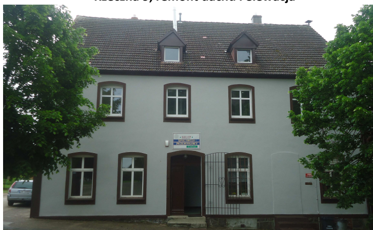
Kluczewo 20, remont elewacji. W tym budynku Spółka wyremontowała pomieszczenia, z których powstały cztery mieszkania komunalne
