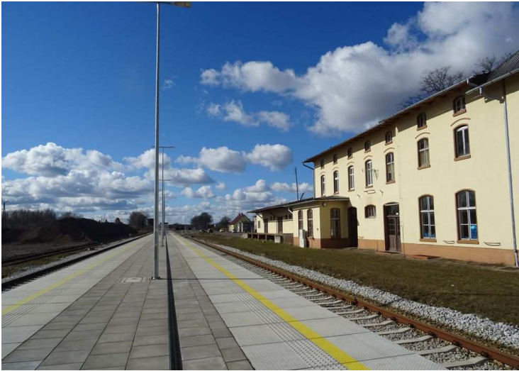
10. Stacja kolejowa po modernizacji, widok w kierunku zachodnim (fot. Zb. Januszaniec, marzec 2021 r.)
