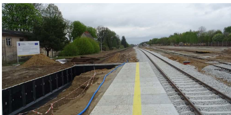
9. Prace modernizacyjne na stacji kolejowej. Na fotografii widać, że jeden tor linii 210 jest już zmodernizowany, (fot. Zb. Januszaniec, kwiecień 2019 r.)
