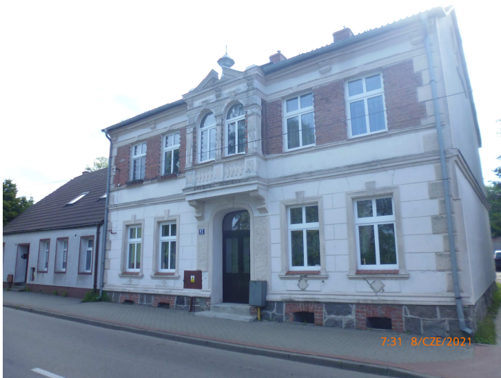
Drahimska 52, remont elewacji
