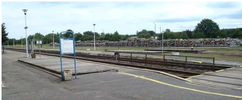
1. Perony z płytami przykrywającymi wejścia do nieczynnego tunelu (źródło: https://www.bazakolejowa.pl , fot. „octanq”, lipiec 2015 r.)
