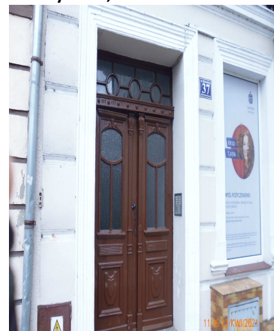
Sikorskiego 37, remont drzwi i remont klatki schodowej
