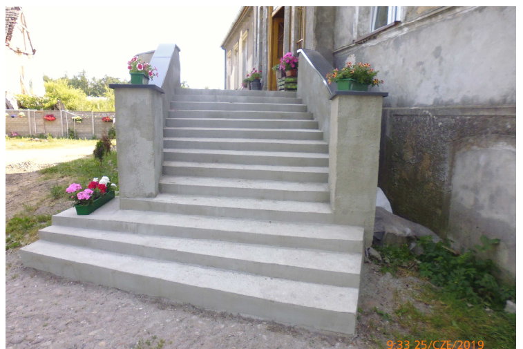
Pałac w Motarzewie - remont schodów
