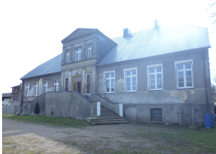
Pałac w Motarzewie po remoncie dachu i schodów
