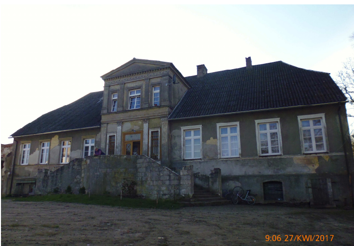
Pałac w Motarzewie przed remontem
