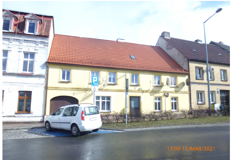
WM Wałęcka 11 - remont dachu
