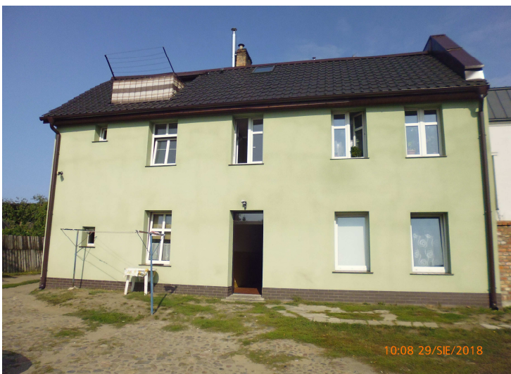
Wspólnota Mieszkaniowa ul. Rzeźnicka 7 elewacja i remont korytarza
