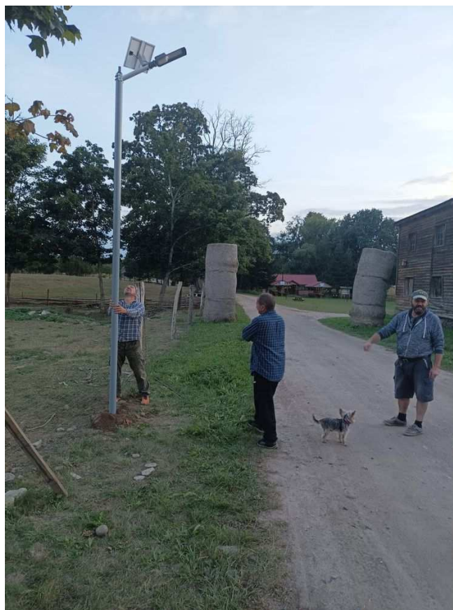
Montaż lampy solarnej w Żeliszawiu
