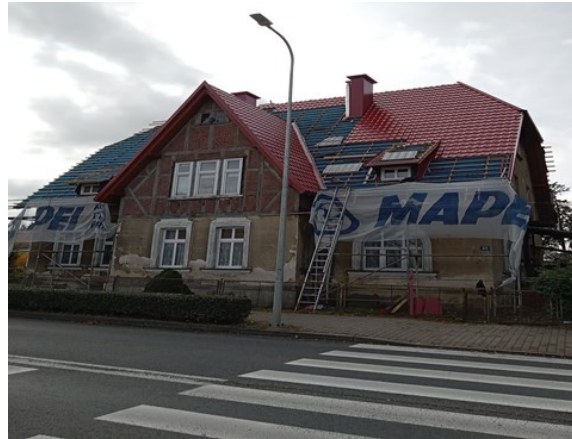
Wspólnota Mieszkaniowa ul. Wałęcka 40. Inwestycja: nowe pokrycie dachu, remont kominów.
