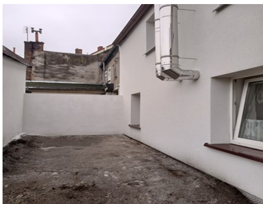
Wspólnota Mieszkaniowa ul. Wałęcka 11. Inwestycja: remont elewacji z ociepleniem ścian.
