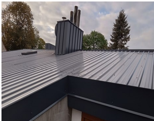
Wspólnota Mieszkaniowa ul. Moniuszki 24. Inwestycja: nowe pokrycie dachu, remont kominów.
