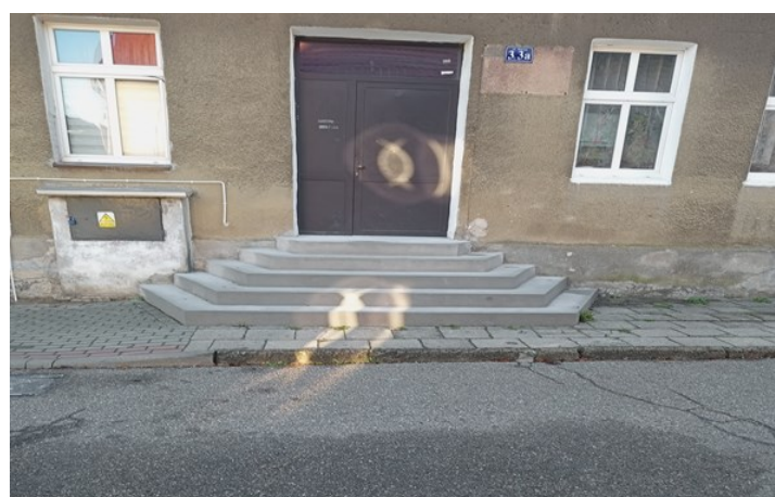
Wspólnota mieszkaniowa nieruchomości ul. Górna 3a. Inwestycja: remont schodów zewnętrznych.
