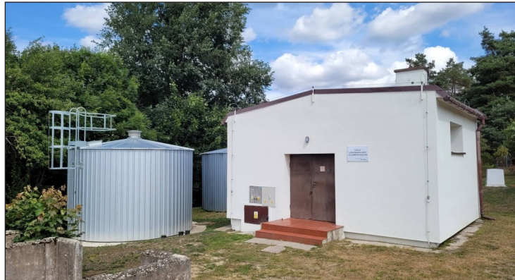
Modernizacja ujęcia i stacji wodociągowej w m. Czarnie Wielkie
