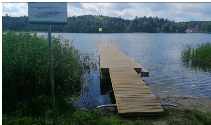
Budowa trzech pomostów rekreacyjnych na terenie gminy Czarnie w m. Machliny, Głęboczek i Piaseczno
