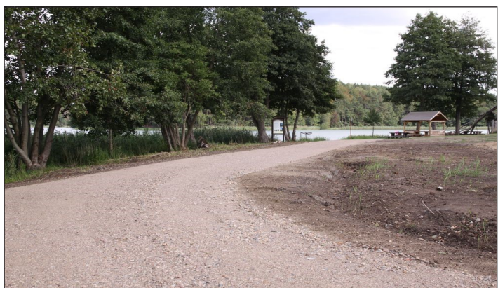
Remont drogi wewnętrznej do jeziora Komorze w Sikorach
