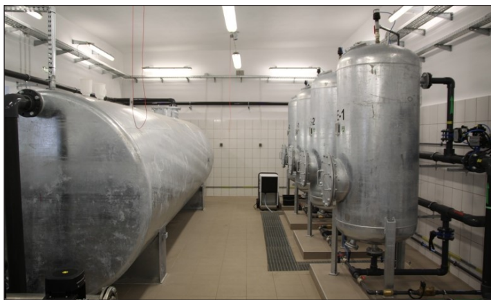
Modernizacja ujęcia i stacji wodociągowej w m. Czarnie Małe
