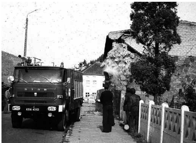
Rozbiórka stodoły przy ul. Szczecineckiej.
