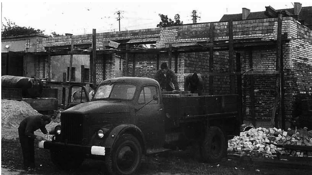
Rozbudowa strażnicy przy ul. Pławieńskiej.
