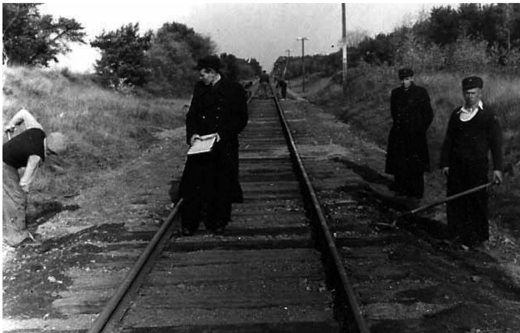
Lata 50-te. St. Januszaniec nadzorujący prace torowe na linii Choszczno Złocieniec.
