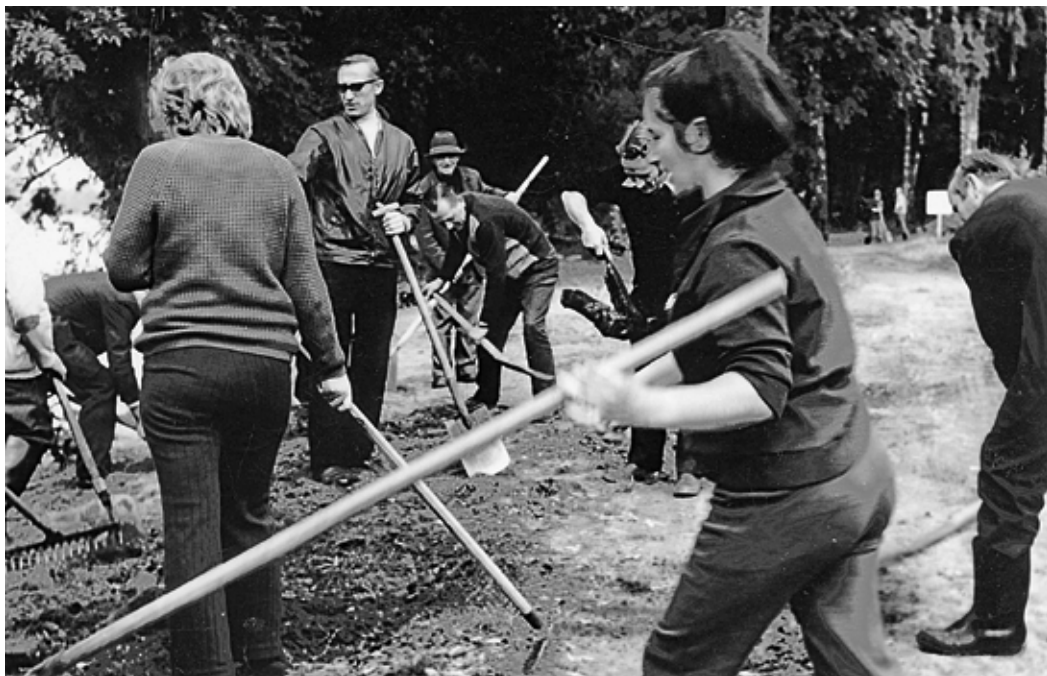
Pracownicy czaplineckiej służby zdrowia przy budowie amfiteatru.
