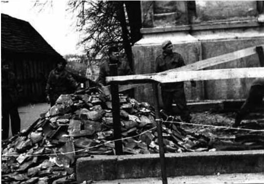
Prace strażaków przy dachu kościoła.
