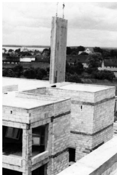
Budowa szkoły podstawowej.
