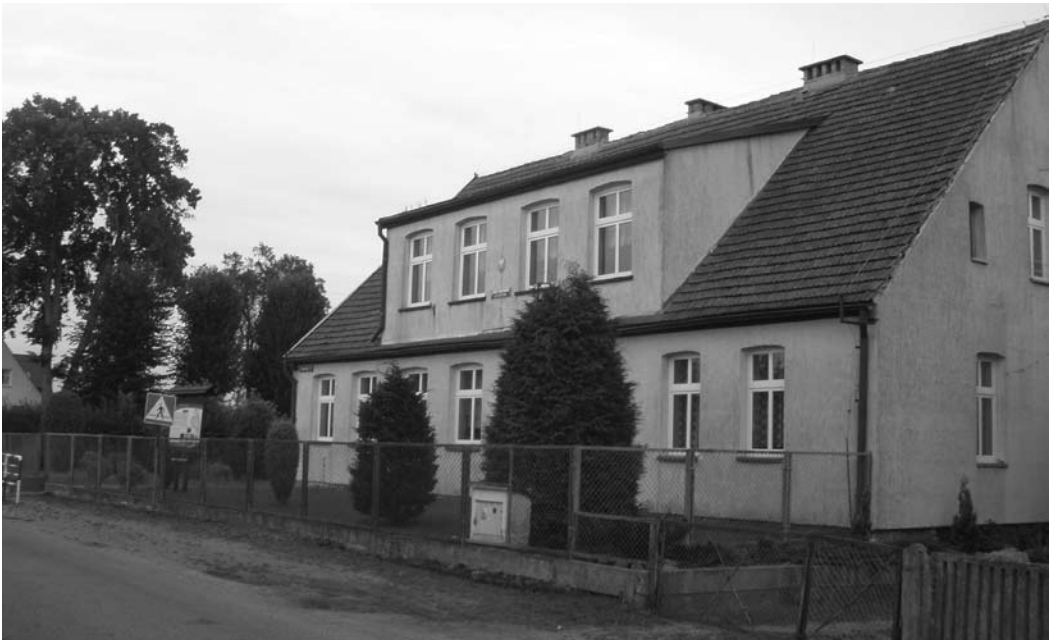
Zdjęcie z ostatnich dni sierpnia 2009 r. Za kilka dni szyld zniknie z budynku – to już nie będzie szkoła.
