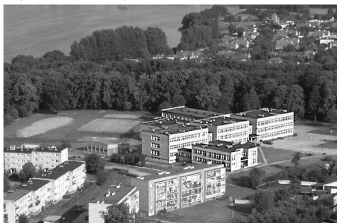
Szkoła Podstawowa - widok przed budową hali widowiskowo-sportowej.
