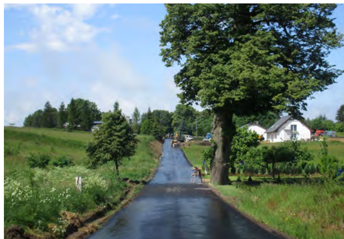
Prace budowlane na drodze do miejscowości Niwka
