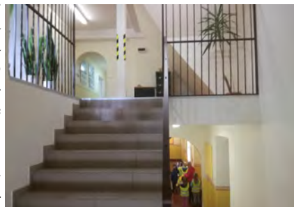
Wyremontowana klatka schodowa
