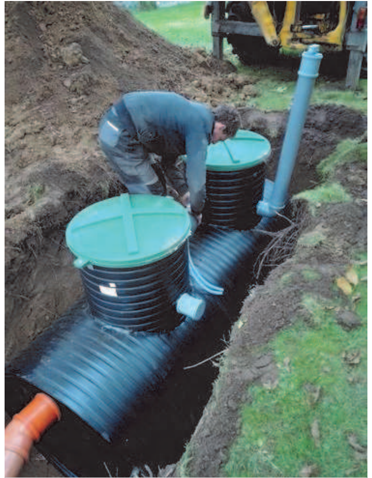
Montaż przydomowej oczyszczalni ścieków
