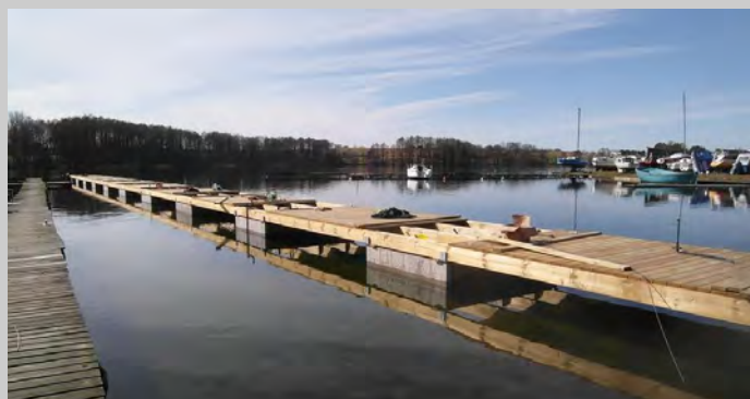
Prace nad budową pomostu
