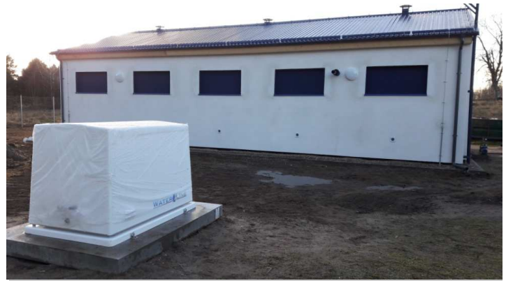
Nowa elewacja budynku stacji wodociągowej w Starym Drawsku
