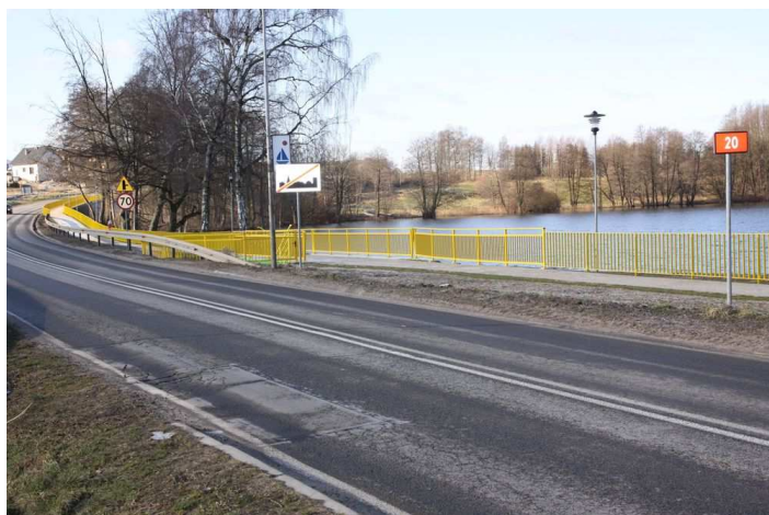
Nowa ścieżka przy ul. Złocienieckiej
