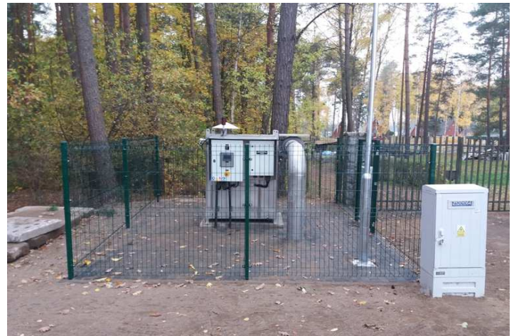
Przepompownia koło Starego Drawska
