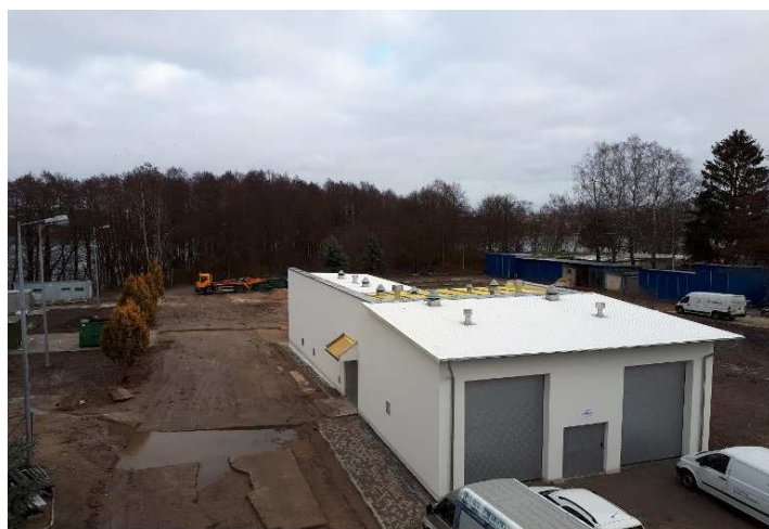
Obiekt gospodarki osadowej
