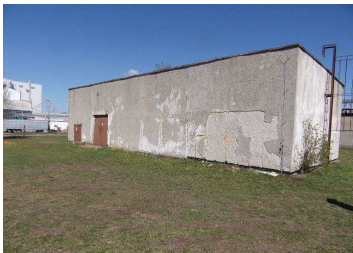
Stacja wodociągowa przed modernizacją
