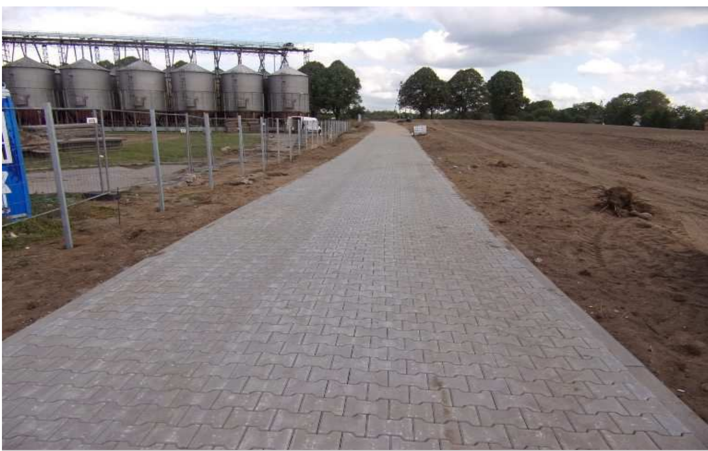
Droga do stacji i ujęcia wodociągowego
