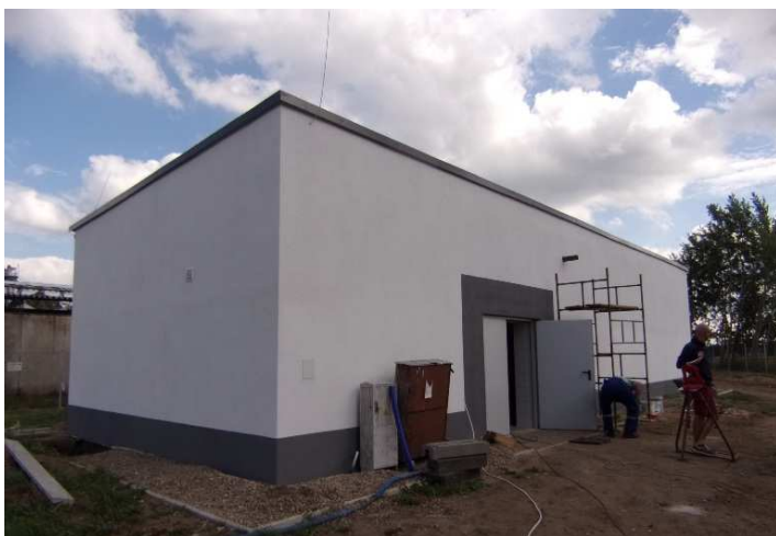
Nowa elewacja budynku stacji
