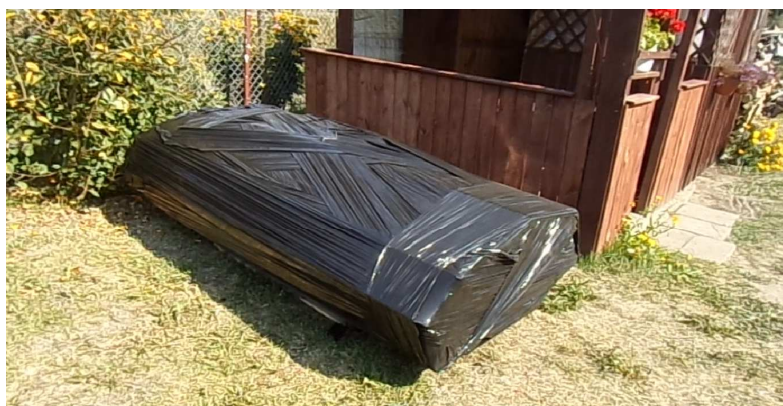
Ściągnięty, owinięty i oczekujący na zabranie azbest
