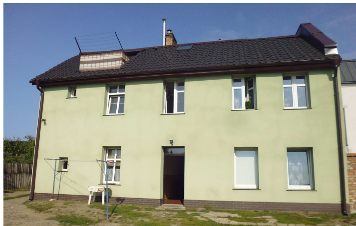
Wspólnota Mieszkaniowa Rzeźnicka 7 remont dachu i elewacji
