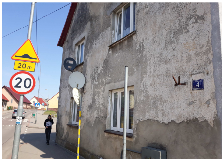
Budynek przed remontem
