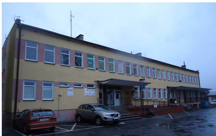
Przychodnia Zdrowia Wałęcka 54 A remont dachu i elewacji
