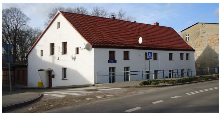
Wspólnota Mieszkaniowa Drahimska 1, remont dachu i elewacji
