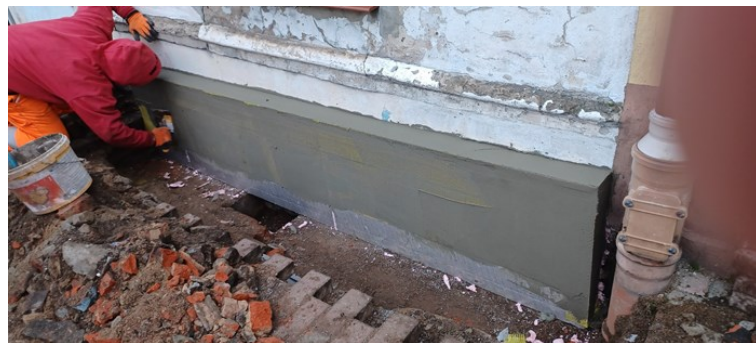
2. Wspólnota Mieszkaniowa Nieruchomości ul. Wałęcka 9—izolacja fundamentów
