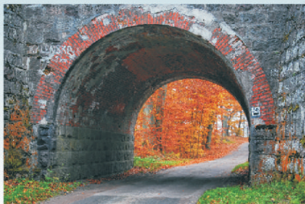
Zabytkowy wiadukt kolejowy
