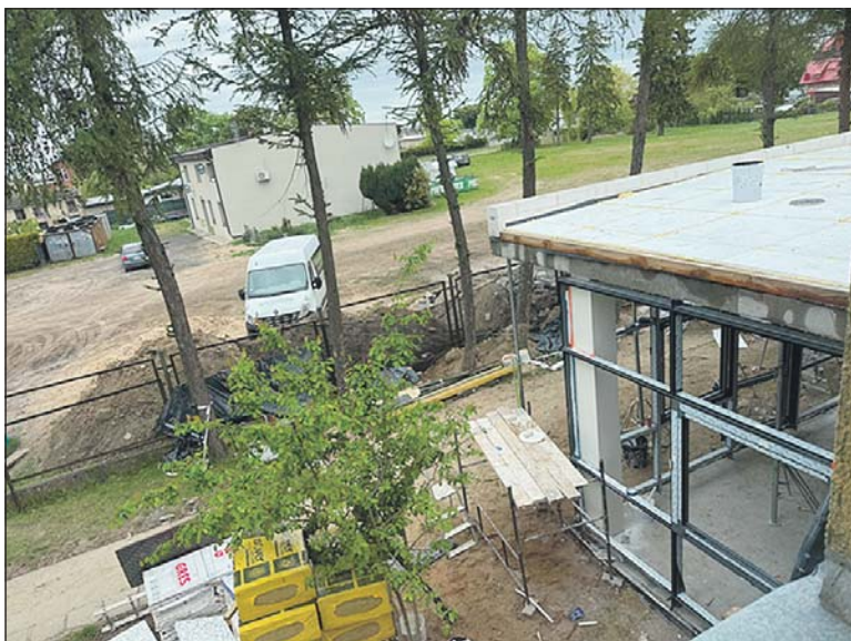
Przebudowa wejścia do budynku
