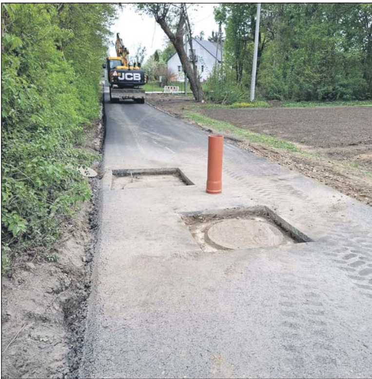
Nowa nawierzchnia drogi w Kołomacie
