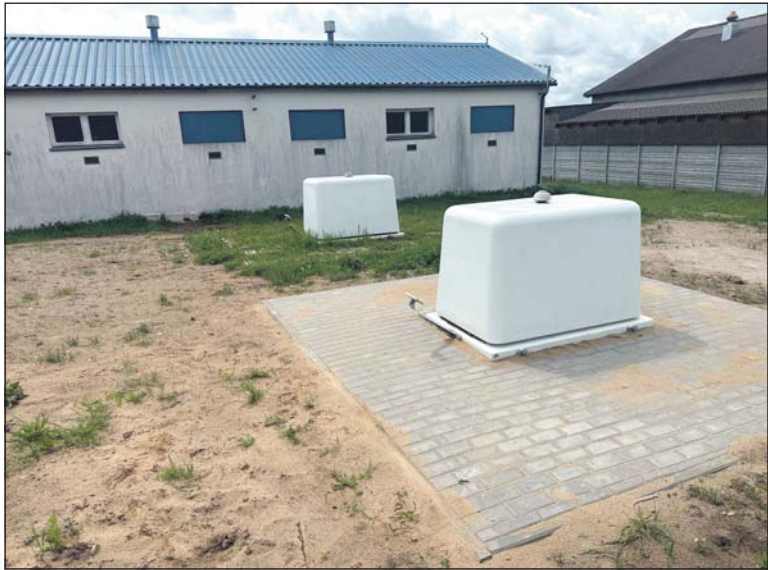
Nowa studnia wodociagowa w Rzepowie
