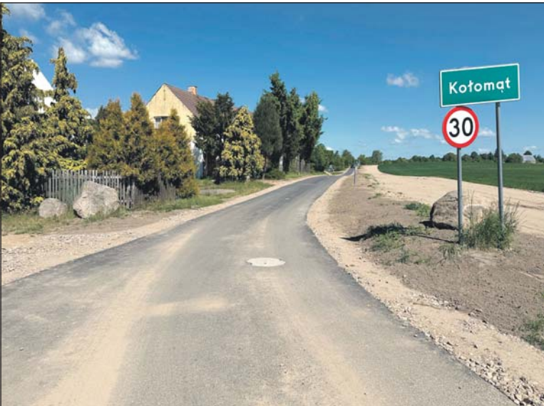
Nowa nawierzchnia drogi w Kołomacie
