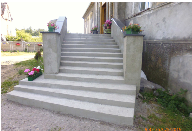
Pałac w Motarzowie - remont schodów
