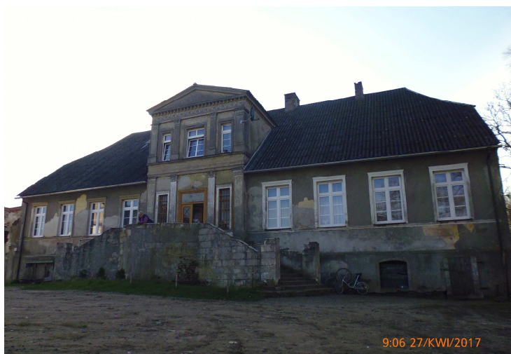
Pałac w Motarzowie przed remontem
