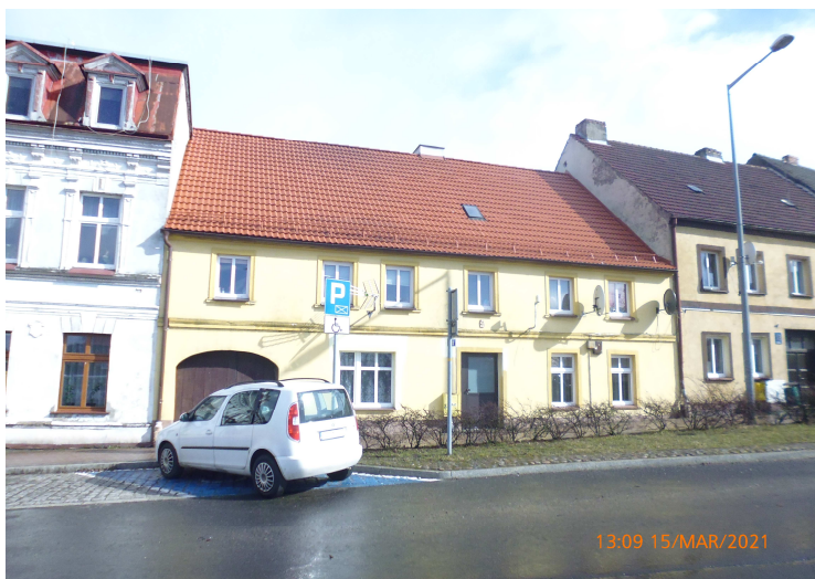
WM Wałęcka 11 - remont dachu
