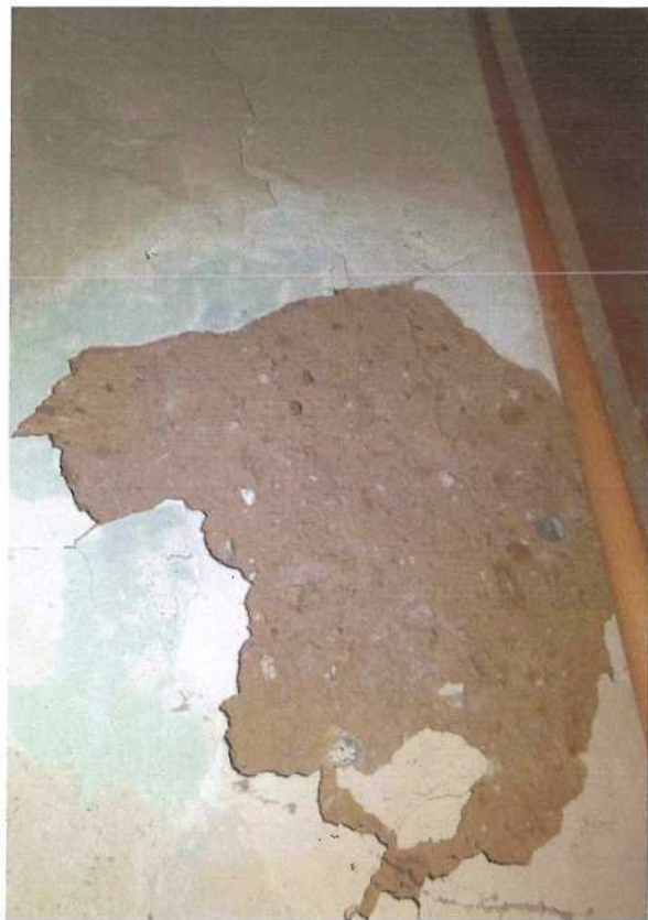
Fot. 22 Skorodowany tynk wewnątrz nawy
