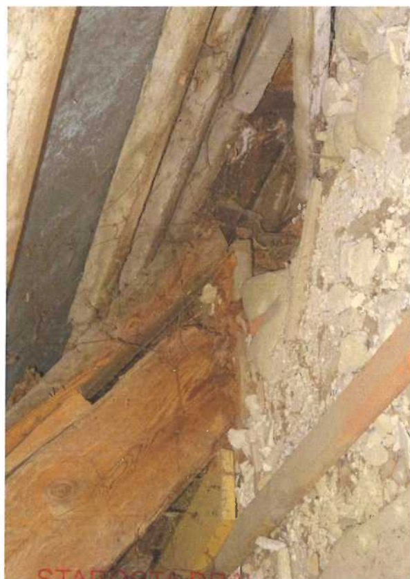
Fot. 28 Skorodowana końcówka krokwi
