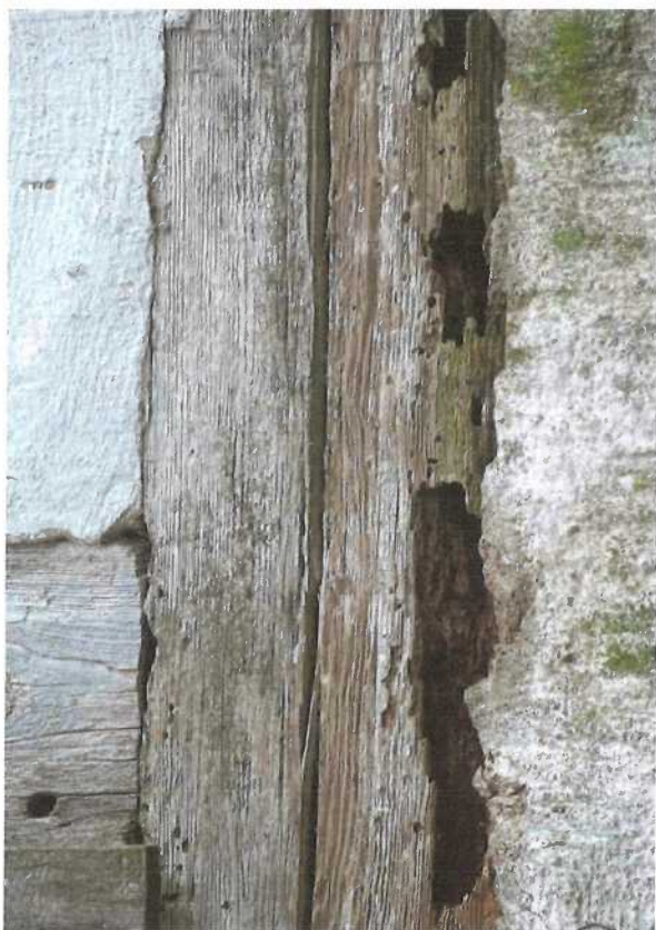
Fot. 15 – Skorodowana podwalina ściany szkieletowej
