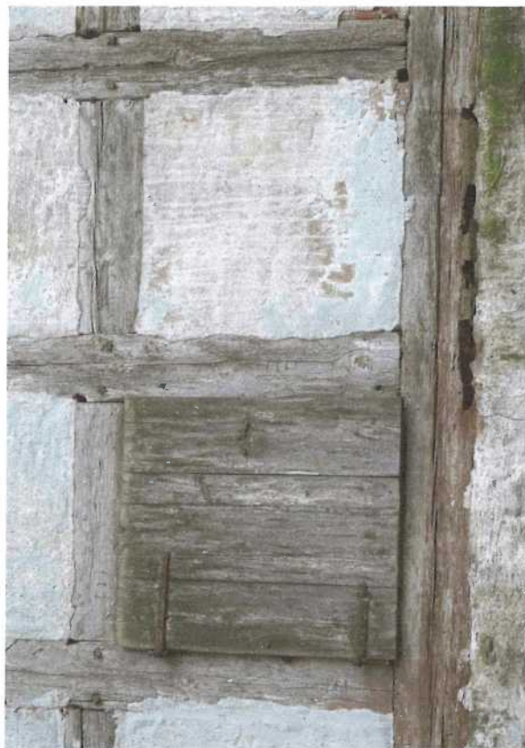
Fot. 14 – Elewacja zach. – fragment szkieletowego szczytu
