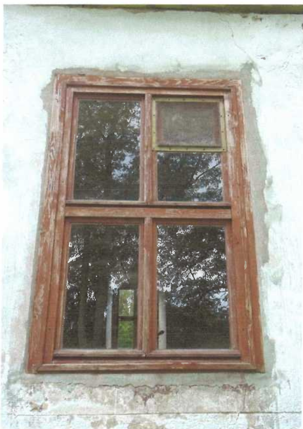
Fot. 7 Elewacja płd. - sposób montażu okna
