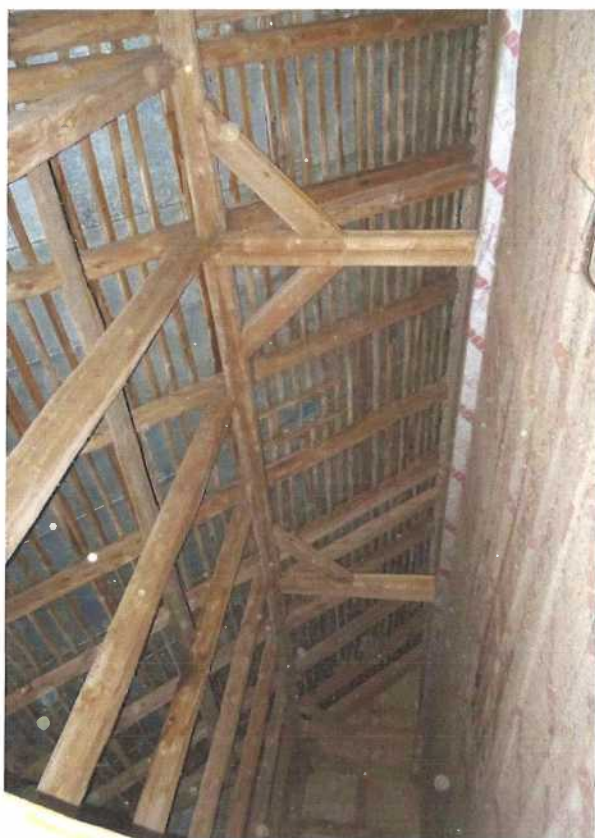
Fot. 27 Poddasze – ścianka stolcowa
