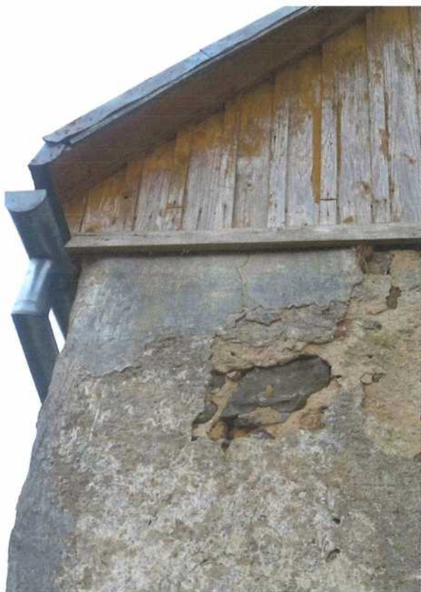
Fot. 11 Elewacja zach. – zniszczenia tynków
