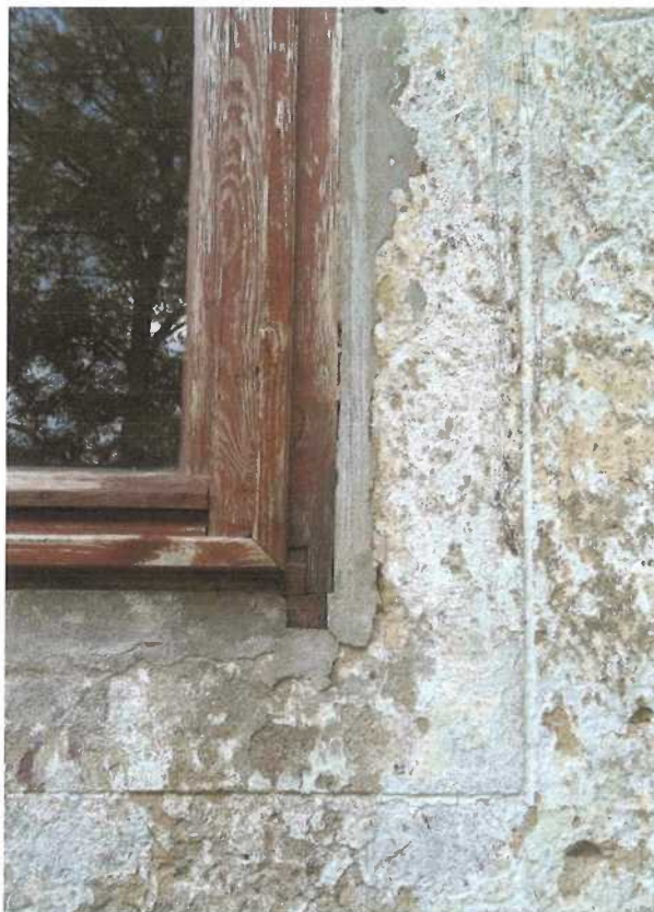
Fot. 10 Narożnik okna – ślad po opasce okiennej, cementowe zaprawy klejowe użyte do mocowania okna
