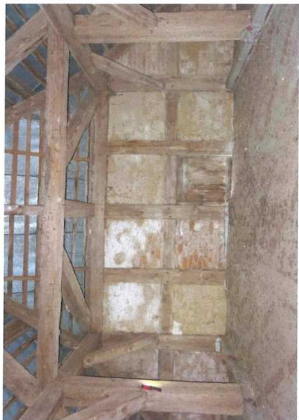
Fot.. 24 Szkieletowa ściana szczytu wschodniego
