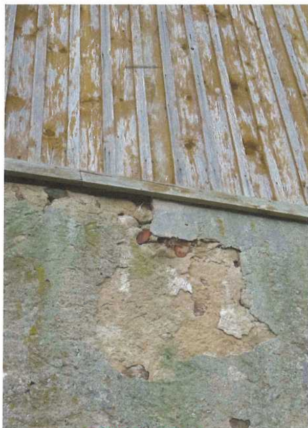
Fot. 12 Elewacja zach. – zniszczenia tynków STAROSTA DRAWSKI Pl. E. Orzeszkowej 3 78-500 Drawsko Pomorskie
