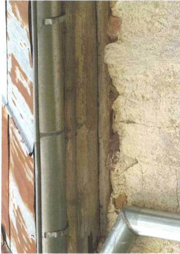
Fot. 17 – Belka okapowa, skorodowane pokrycie dachowe
